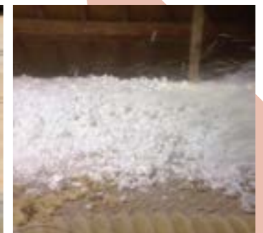
Isolation des combles de la Mairie et de l'école
