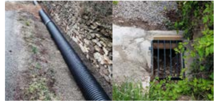
Pose d'un tuyau annelé
