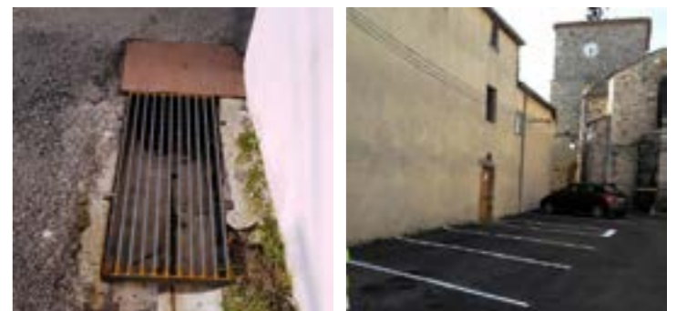
Réalisation d'une grille avaloir rue des Platanes
