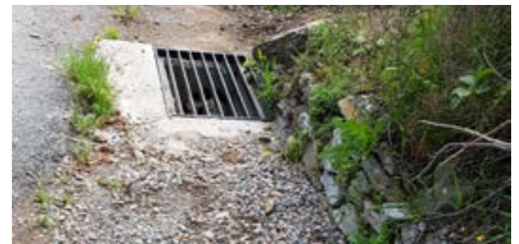
Réalisation d'une grille sur mesure en aval
